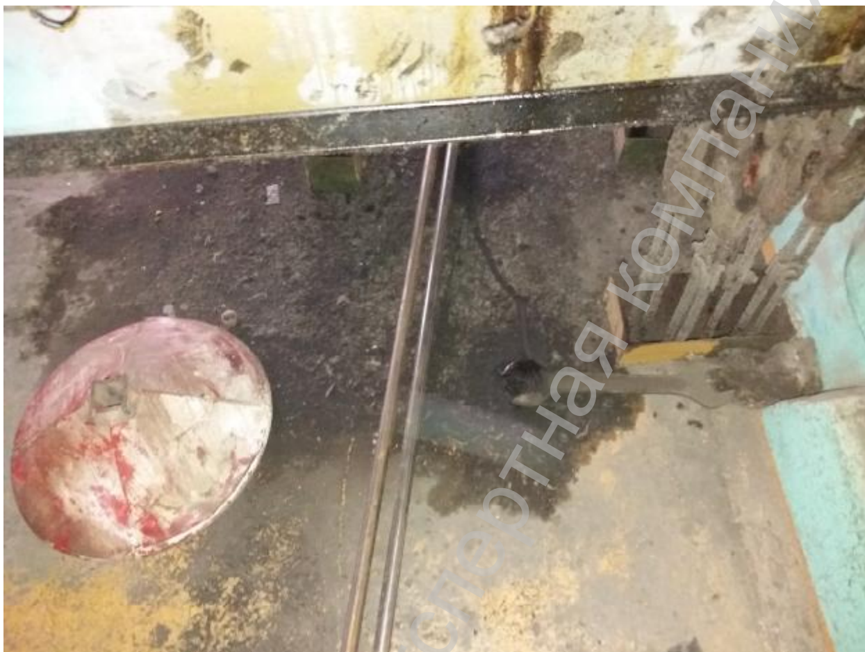
Фотоиллюстрация 21. Пол в МП загрязнен маслом, замусорен.
