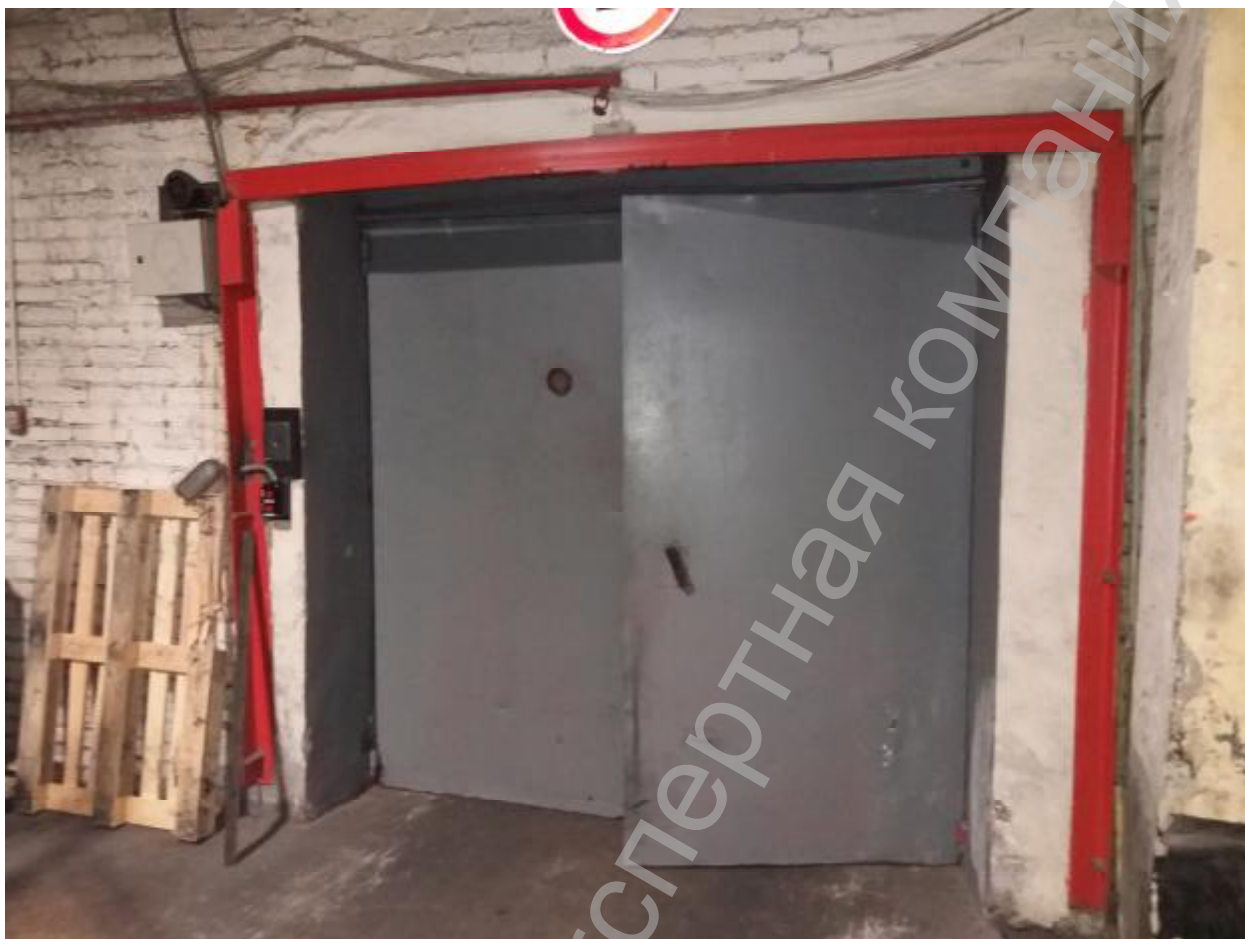
Фотоиллюстрация 2. Двери шахты лифта на 2 остановке.
